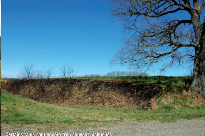
Certains talus sont encore trop souvent malmenés
