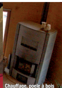
Chauffage, poêle à bois
