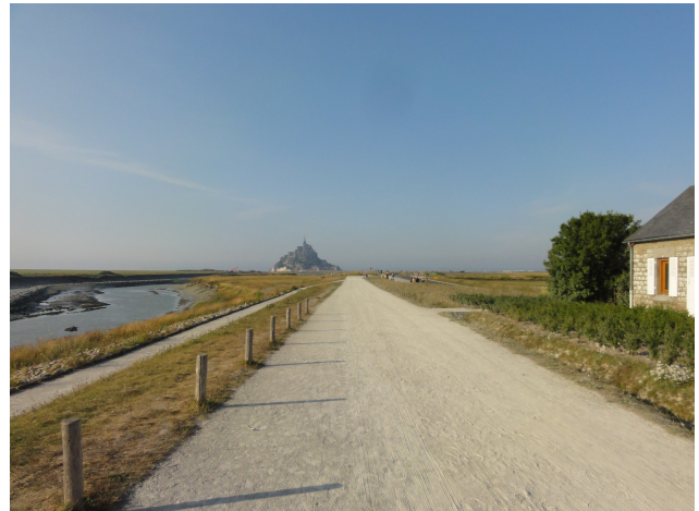
Chemin de la digue en amont du barrage
