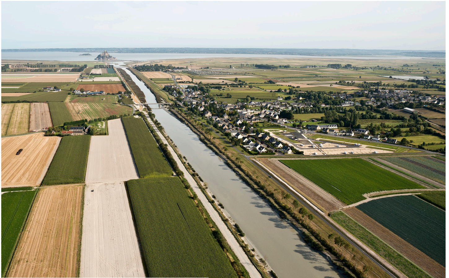
Vue du Couesnon après curage- Photo ANTEA
