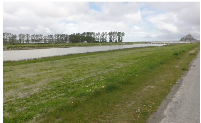
Chemin de la digue en aval du barrage
