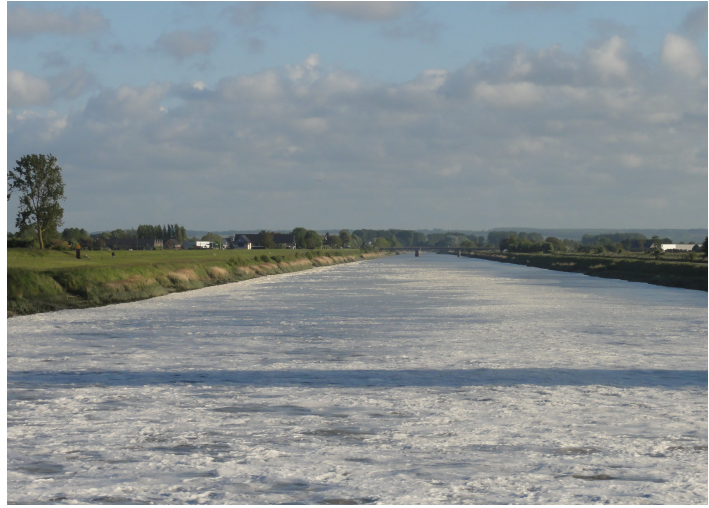
Marée montante, vue coté Beauvoir en amont du barrage
