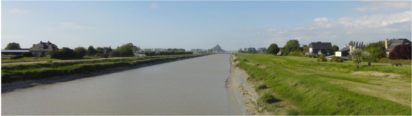
Lacher d'eau, vue coté Beauvoir en amont du barrage
