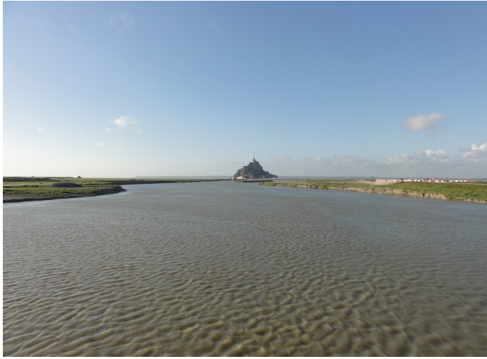
Après le lacher d'eau, coté Mont en aval du barrage
