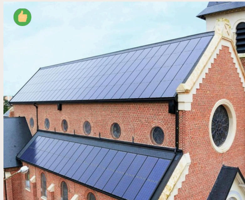
Église, couverte de panneaux photovoltaïques (Loos-en-Gohelle, Pas-de-Calais)
