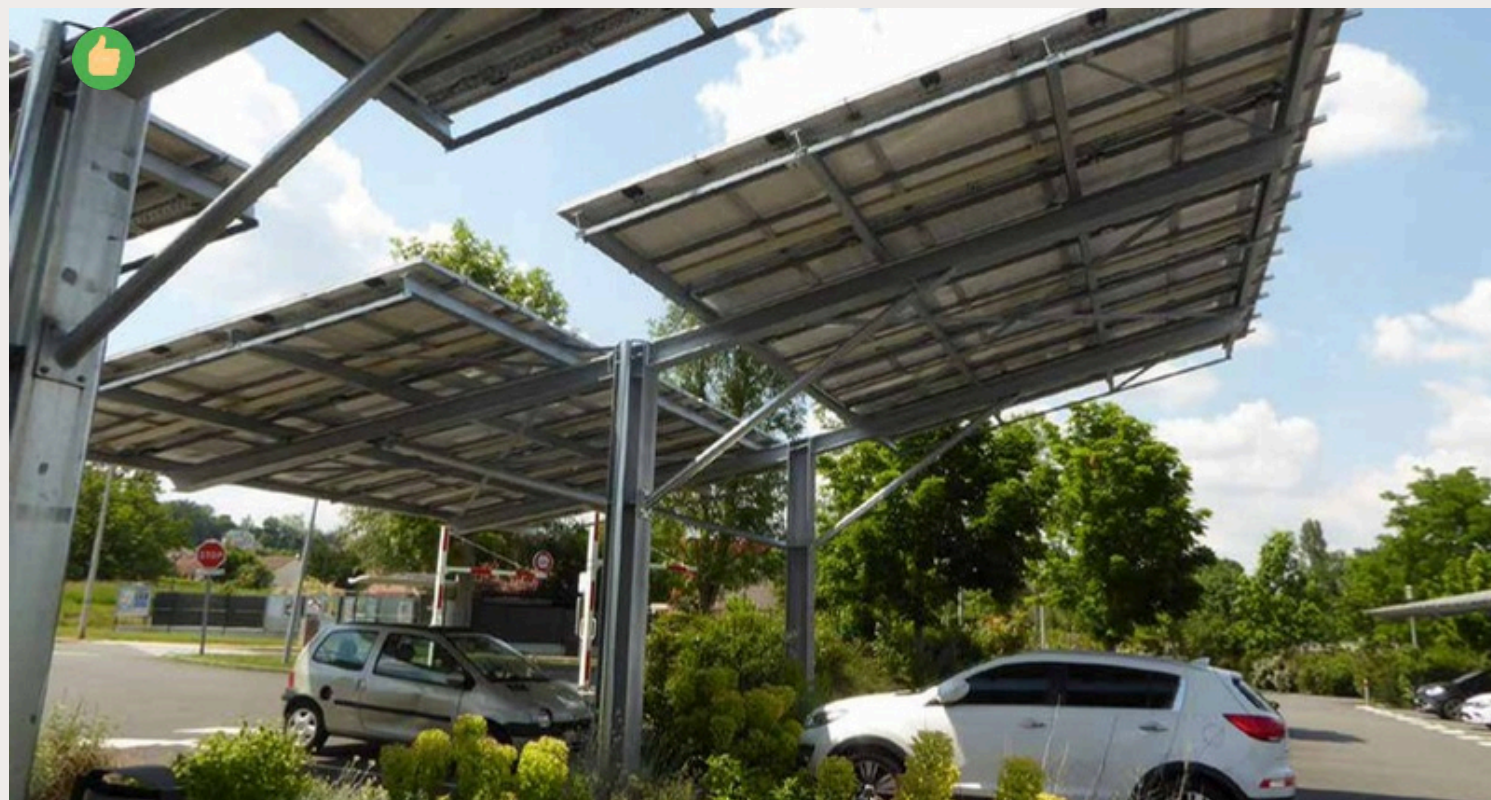
Exemple d'ombrières mêlées à la végétation (Allier, source : internet)
