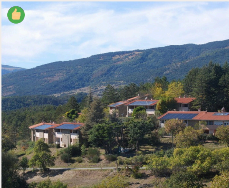
Le village de Rosans, pionnier des centrales villageoises, a développé un projet cohérent grâce à plusieurs études paysagères et architecturales à différentes échelles, du site à la toiture en passant par le village (Hautes-alpes)
