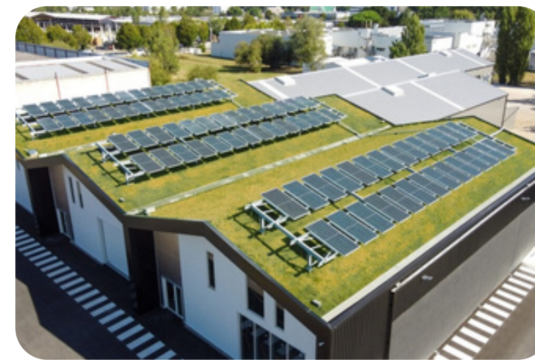
Toiture biosolaire installée sur La Fabrik, bâtiment à Pessac. Image : Vegetek (internet)
