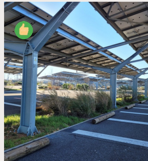
Exemple d'ombrière photovoltaïque récupérant les eaux pluviales dans des bandes et noues plantées (Gard)
