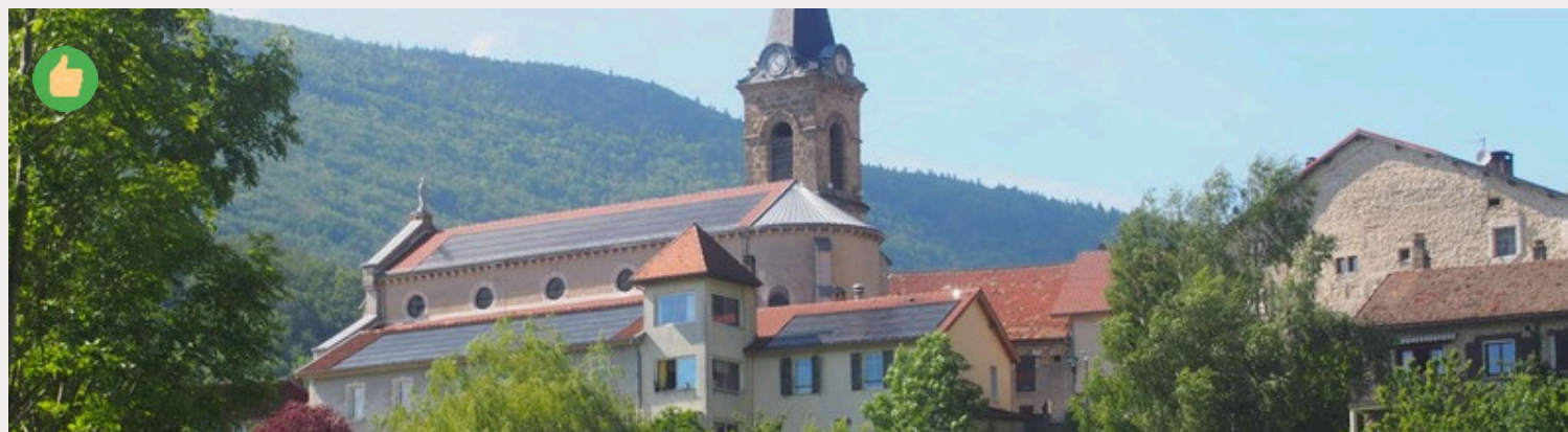
Exemple de centrale villageoise à panneaux intégrés aux toitures (Isère)
