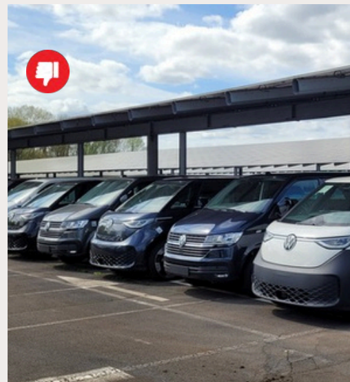
Cas d'ombrière trop exclusivement minérale (Nord)
