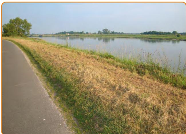
Voie cyclable sur une levée de Loire, dans la campagne agricole : choix d'un enrobé classique gris, en accord avec les services assurant l'entretien des digues et levées. L'enrobé classique peut être une bonne solution, à condition de limiter drastiquement la largeur, supprimant ainsi l'effet routier.
