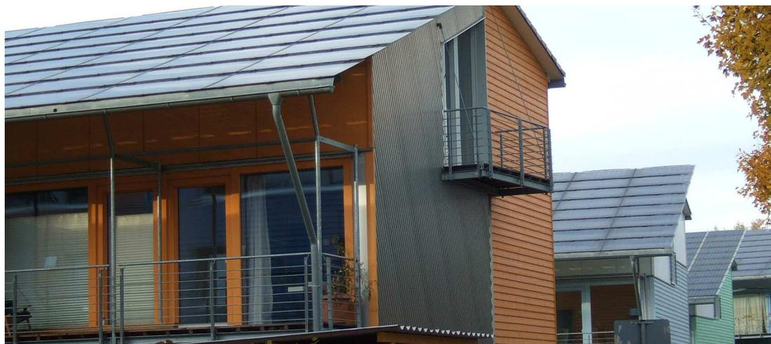
Panneau solaire faisant office de couverture "Toiture intégrée" dans la "Solarsiedlung" à Fribourg, Allemagne.
