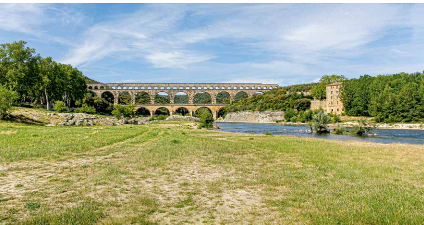
Vue amont Le pont romain, le pont Pitot et le vieux moulin.
