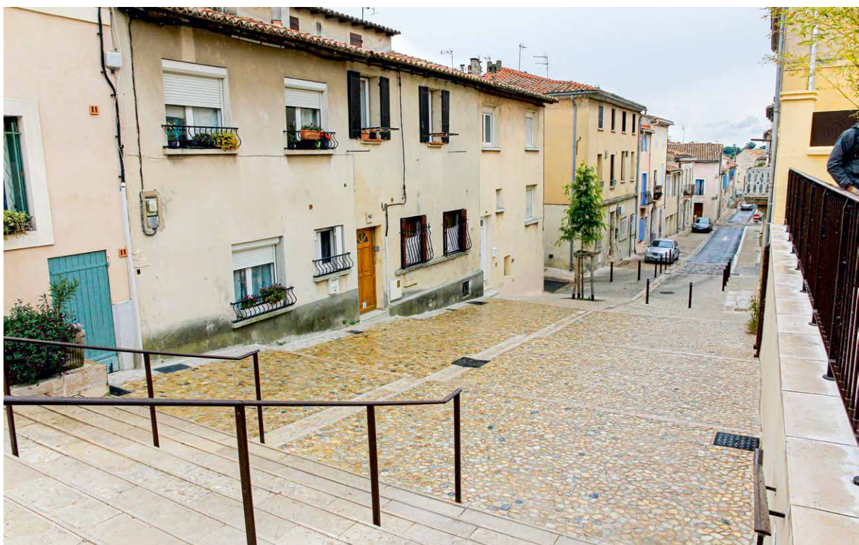
Rue Victor-Hugo, l'escalier restitué limite la circulation des véhicules.
