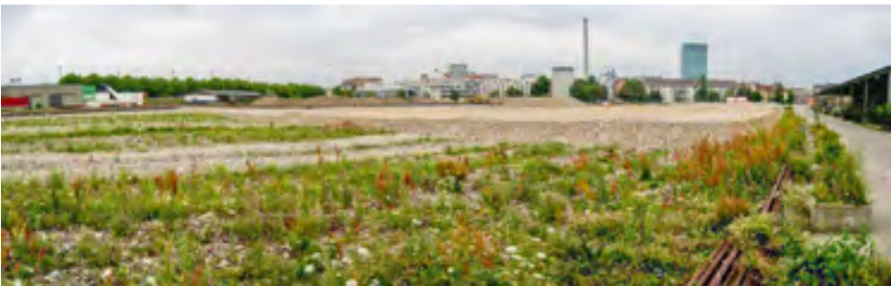
Modelage des terrains pendant le chantier.
